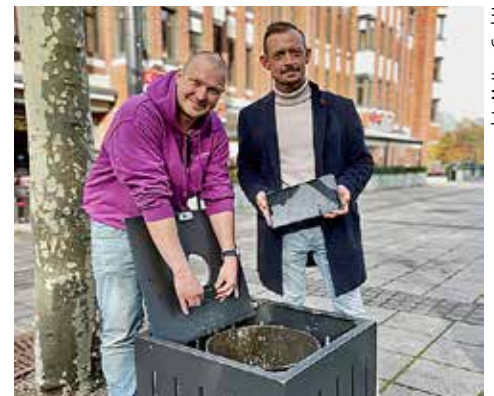
Grevenbroich: Rund 40 Sensoren installiert.*
