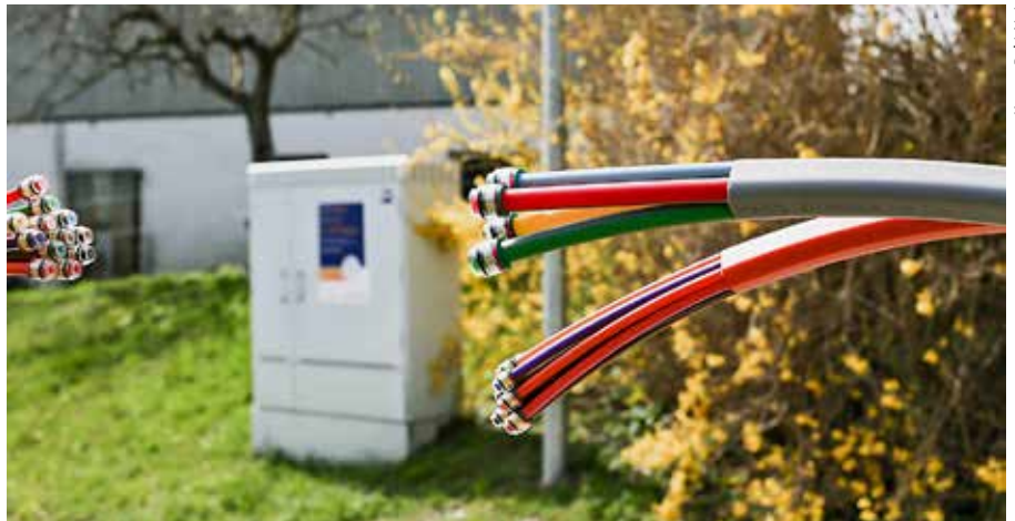
Mit einer Projekt-Management-Plattform den Überblick über den Breitbandausbau behalten.
